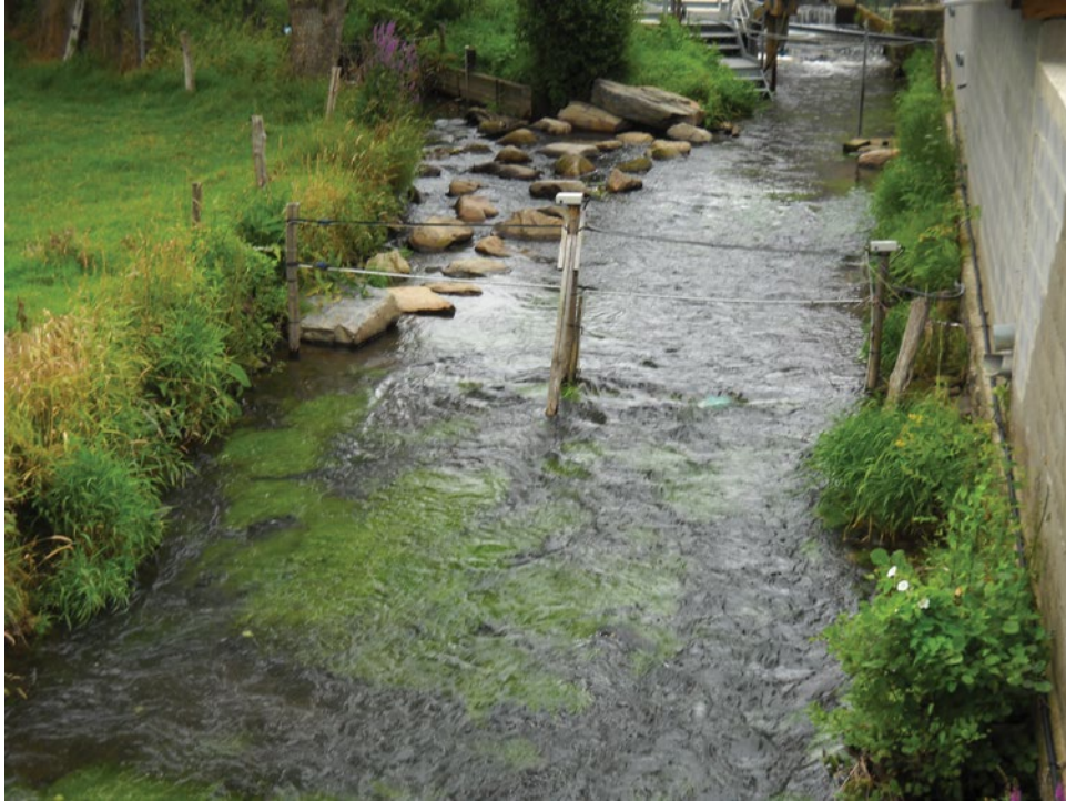
Figure 12. L'Oir en aval du moulin de Cerisel est équipé de deux antennes qui barrent la rivière. Son efficacité est variable. Elle est perturbée par des bruits électromagnétiques. Le site sera bientôt équipé d'un deuxième rideau qui s'accompagnera du rapprochement du lecteur pour en améliorer l'efficacité. (Photo : U3E, INRA).
