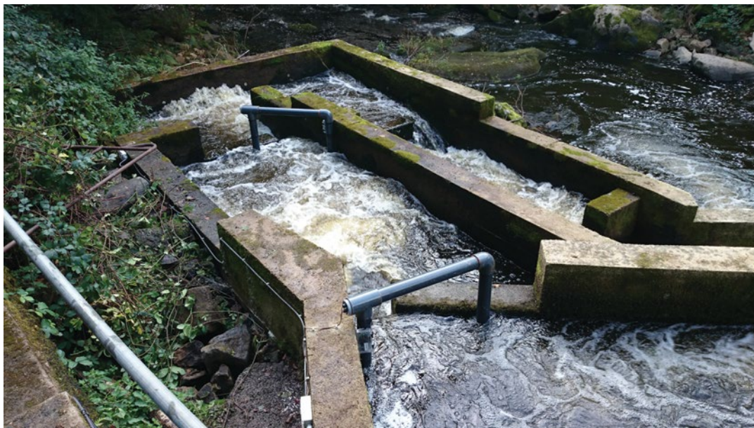
Figure 8. Passe à poisson de Pont Calleck équipée de deux antennes (partie médiane du Scorff) (photo : U3E, INRA).
